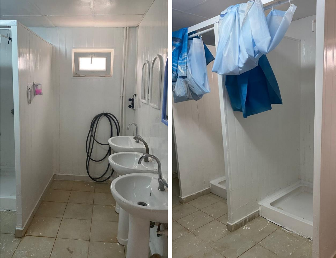
Fotoğraf 4: FTRH'deki İşçi Konaklama Alanında Bulunan Duş Alanlarındaki İyileştirmeler
