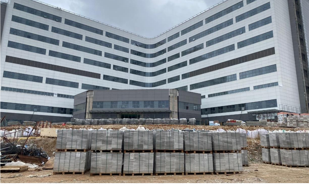
Fotoğraf 1: Genel Hastane Binası İnşaatı Genel Görünümü
