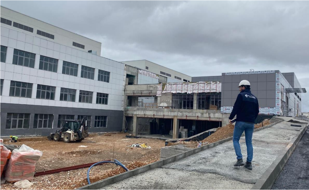
Fotoğraf 2 : FTRH Binası İnşaatı Genel Görünümü
