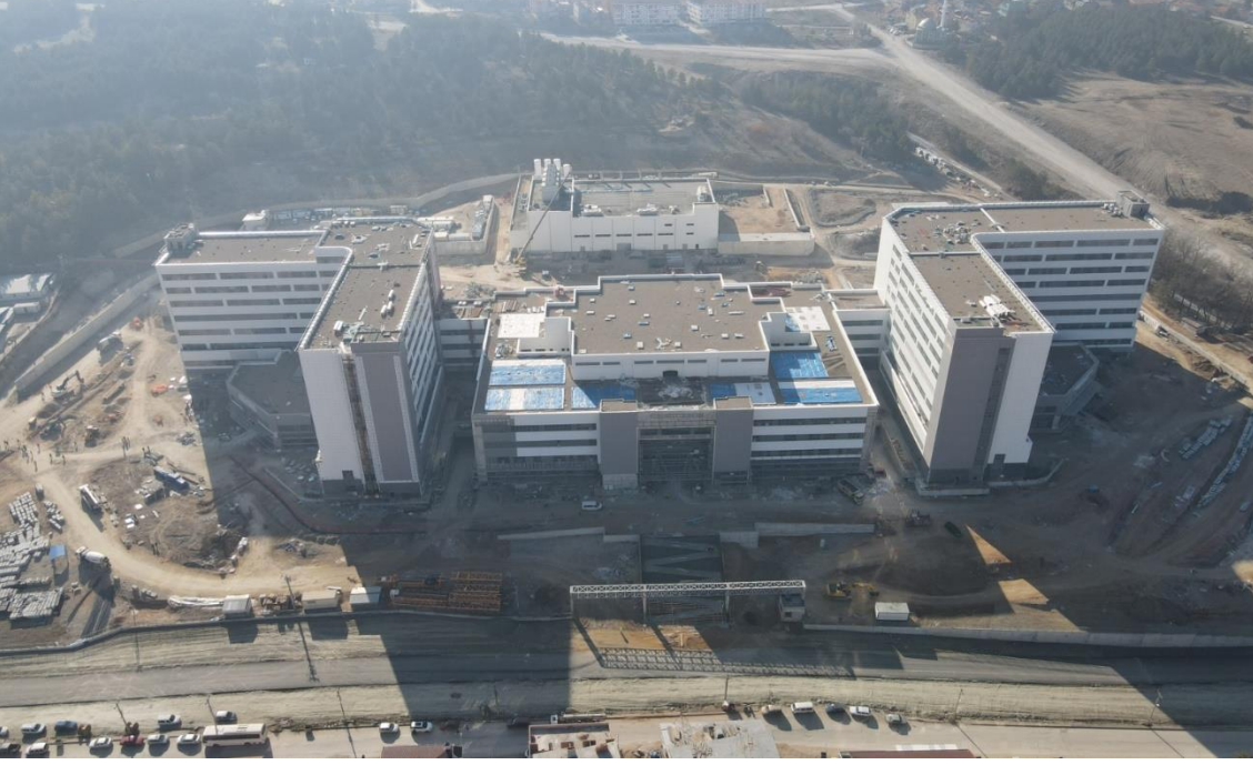
Fotoğraf 1 : Genel Hastane Binası İnşaatı Genel Görünümü
