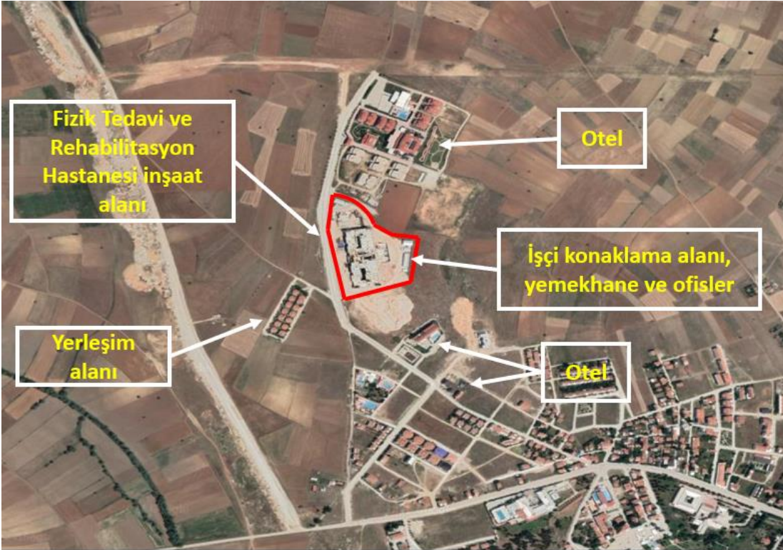
Şekil 1-3: Kütahya İli Yoncalı İlçesindeki Fizik Tedavi ve Rehabilitasyon Hastanesi Sahasının Havadan Görünümü
