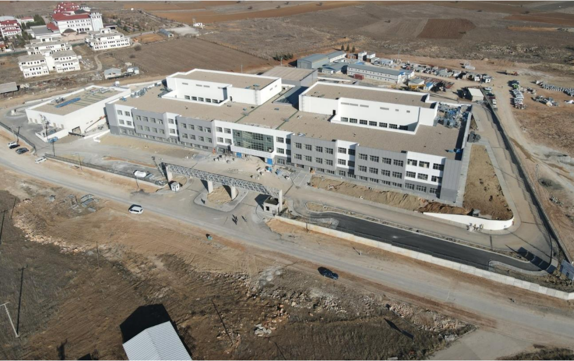
Fotoğraf 2 : FTRH Binası İnşaatı Genel Görünümü
