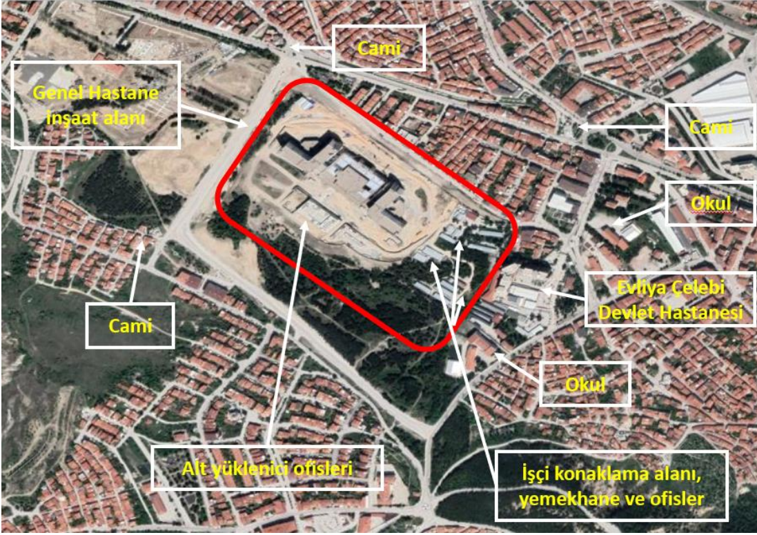
Şekil1-2: Kütahya İl Merkezindeki Genel Hastane Şantiyesinin Havadan Görünümü
