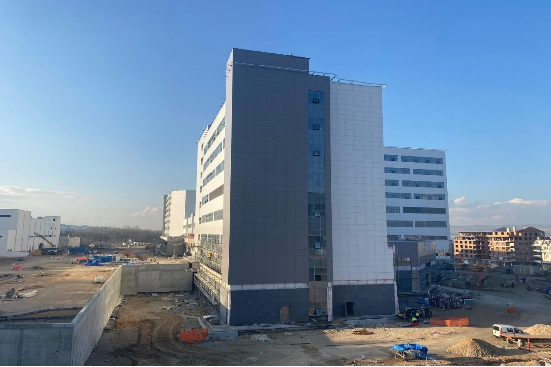
Fotoğraf 1: Genel Hastane Binası İnşaatı Genel Görünümü
