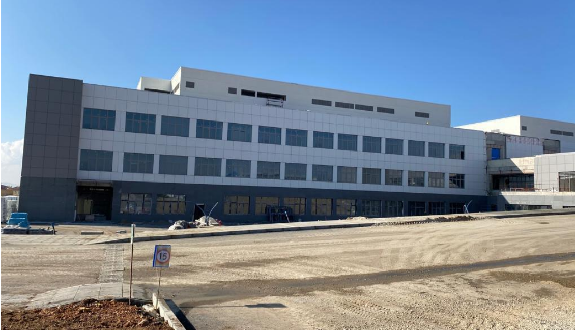
Fotoğraf 3 : FTRH Binası İnşaatı Genel Görünümü
