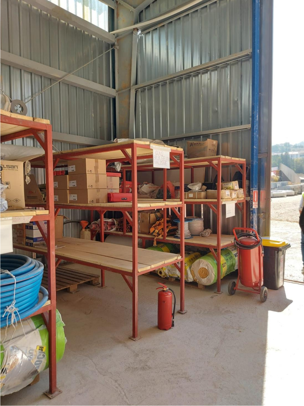
Fotoğraf 8 : Genel Hastane İnşaat Alanındaki Depolama Alanı
