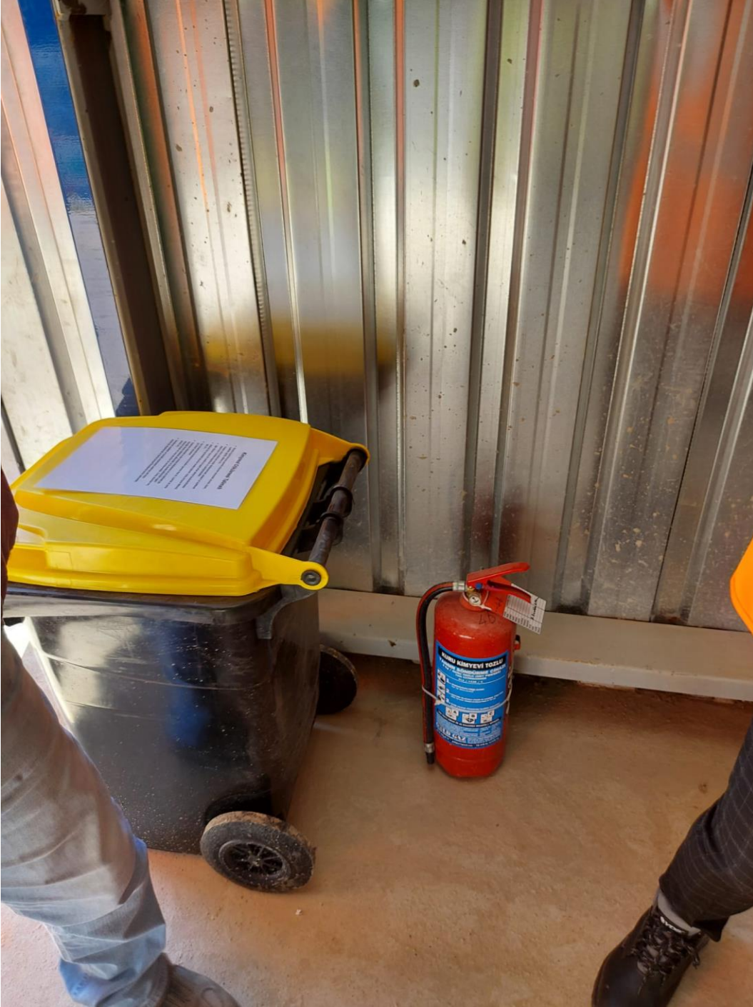
Fotoğraf 9 : Depolama Alanındaki Sızıntı/Döküntü Kiti ve Yangın Söndürücü
