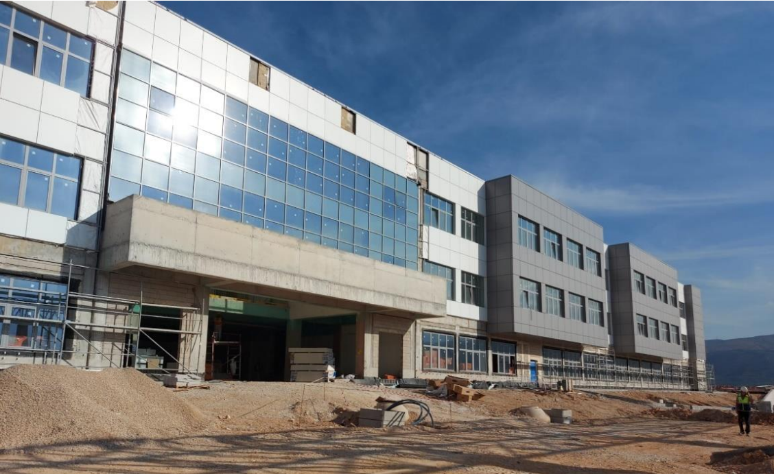
Fotoğraf 2 : FTRH Binası İnşaatı Genel Görünümü
